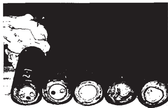
写真-4 塩ビパイプの破損状況
