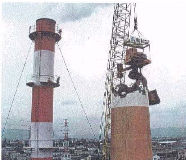
豊中伊丹クリーンランド煙突解体
