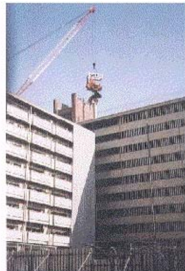
神戸市営本山第1住宅1号棟解体
