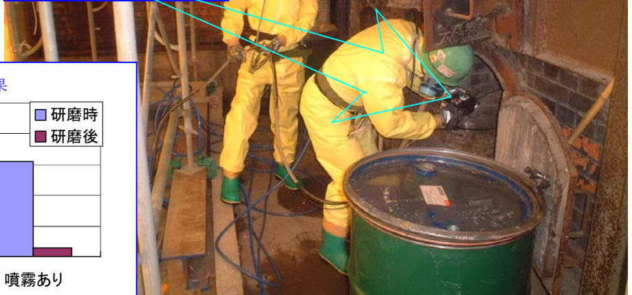
灰出し作業時でのミスト散布状況
