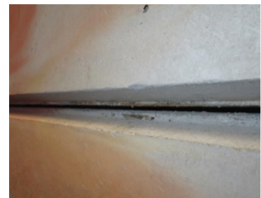
⑥セトル脱型完了(目地部の状況)
