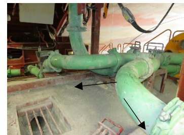
左右同時打設、圧入方式を併用する打設
