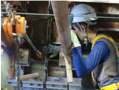
④目地板引抜き
