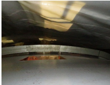
②目地板設置完了(天端部)
