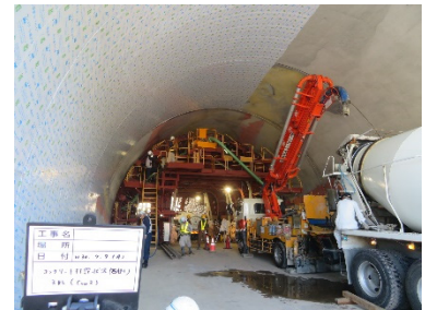
③コンクリート打設
