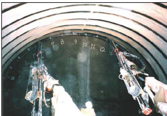
写真-4 鋼管打設状況
