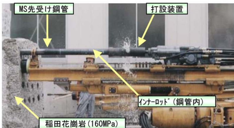
写真-1 鋼管打設システム
