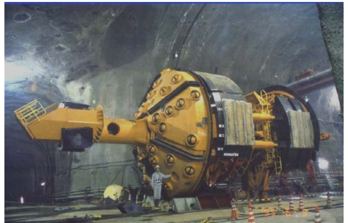
リーミングTBM
