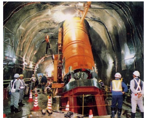
パイロットTBM 発進状況
