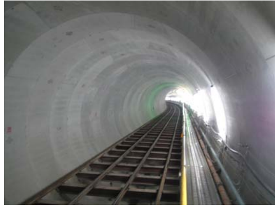
写真-3 一次覆工の仕上がり
