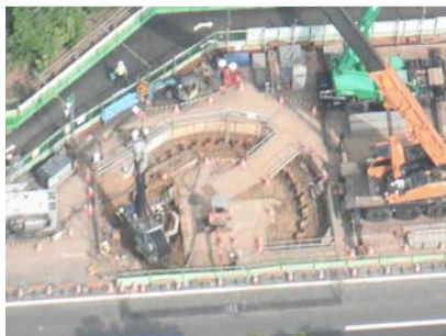
鋼矢板打設状況(上空写真)
