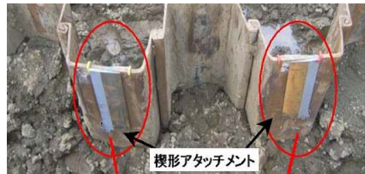
角度補正プレート取付状況
