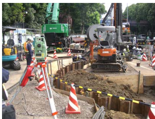
打設位置管理状況
