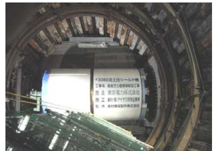
シールド機投入状況
