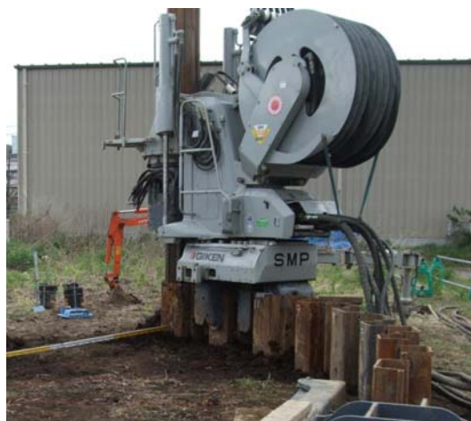
鋼矢板の円形打設状況
