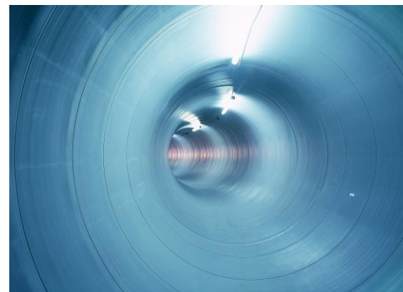
仕上り内径 2,200mm、L=260m の完成状況
