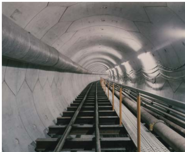
ハニカムセグメント組立状況
