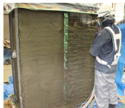
③モルタル吹付け
