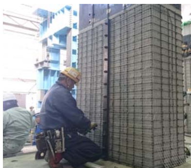
②せん断補強鉄筋の組立
