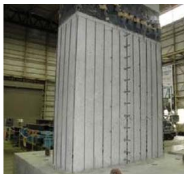
①軸方向鉄筋の設置
