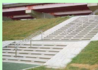
写真-2 階段ブロック
