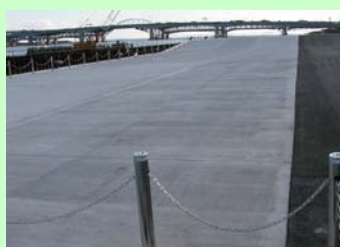
写真-3 舗装コンクリート
