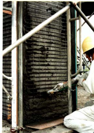
モルタルの吹付け
