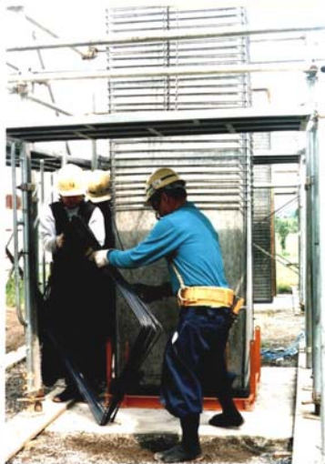
スパイラル鉄筋の装着
