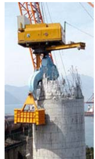
写真-4 NOCC 機による煙突解体
