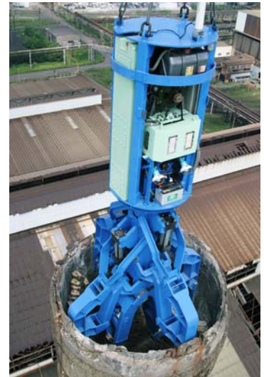
写真-3 レンガ分別解体状況
