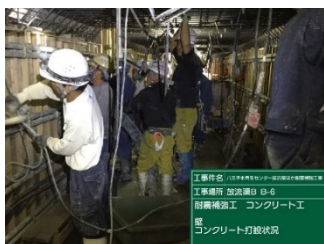
施工当初の打設状況 (多人数)
