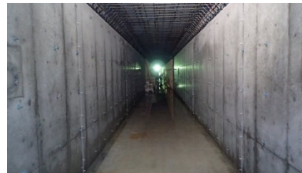
仕上がり状況
