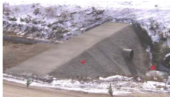
写真-4 上流仮締切堤全景
