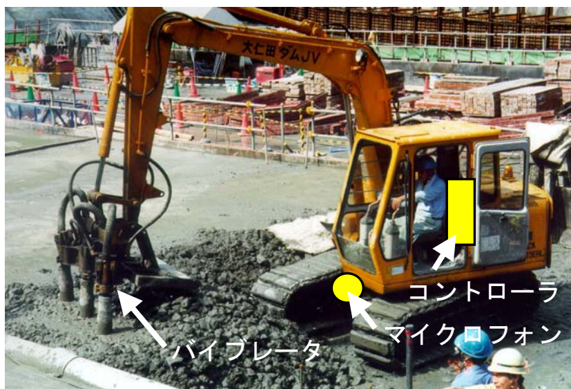
ダムコンクリート締固め状況
