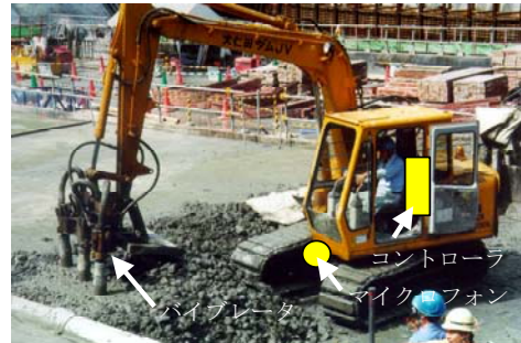
コンクリート締固め状況
