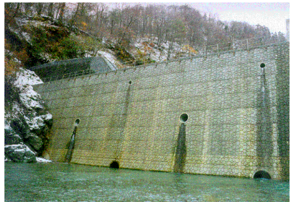
砂防ダム補強工事
