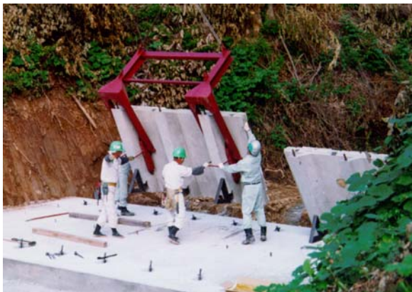
据え付け状況
