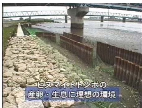
既成直後の状況
