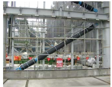
制振ブレースの工事状況
