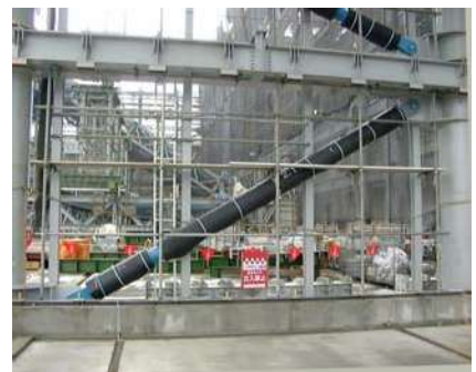
制振ブレースの工事状況
