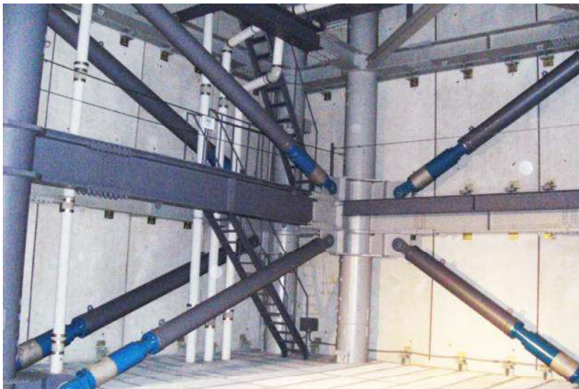
制振ブレースの設置状況（竣工）
