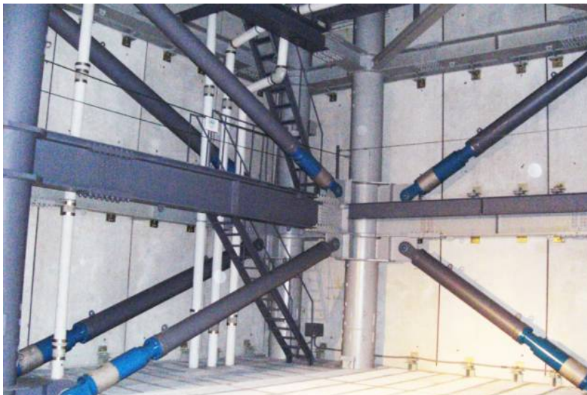
制振ブレースの設置状況（竣工）
