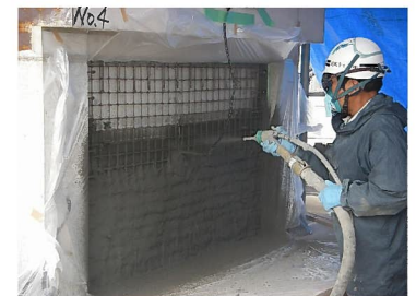
モルタル吹付け状況
