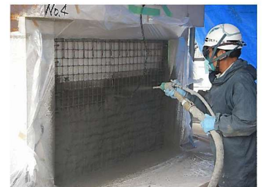
モルタル吹付け状況
