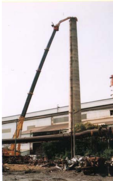
煙突の解体状況
