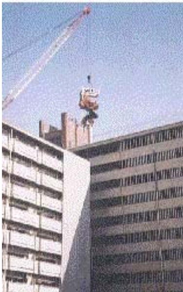
高層構造物の解体状況
