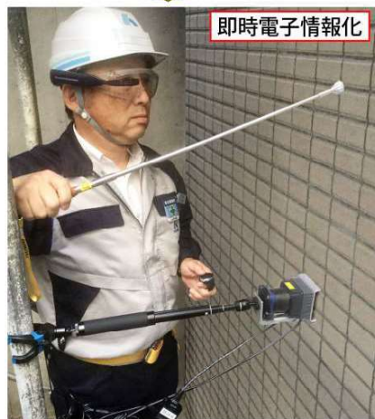
写真2 打診調査作業状況(イメージ)
