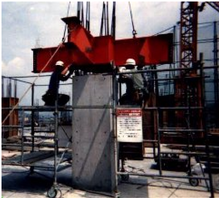
柱梁接合部鉄骨の取り付け状況
