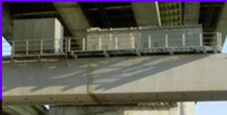
電気施設移設
