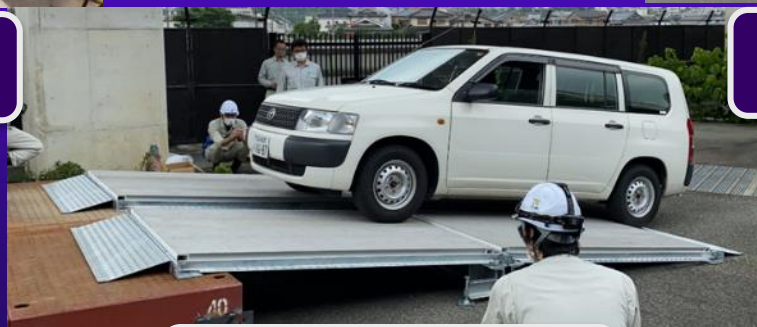
FRP段差解消
