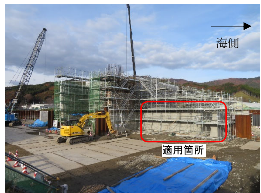
写真-2 脱型後の状況
