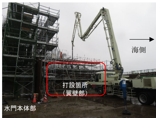
写真-1 打設状況
