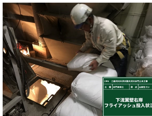
写真-3 フライアッシュ投入 (内包用袋に水解紙充填袋を使用)
