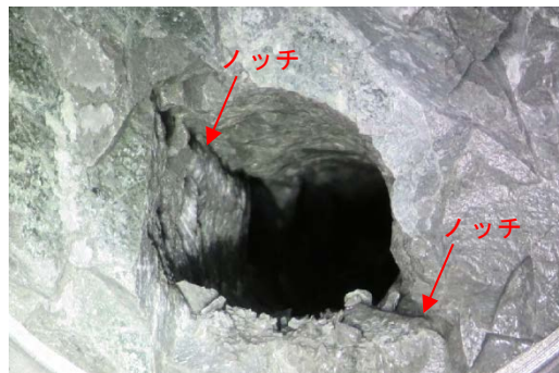
図-2 装薬孔におけるノッチの形成状況
