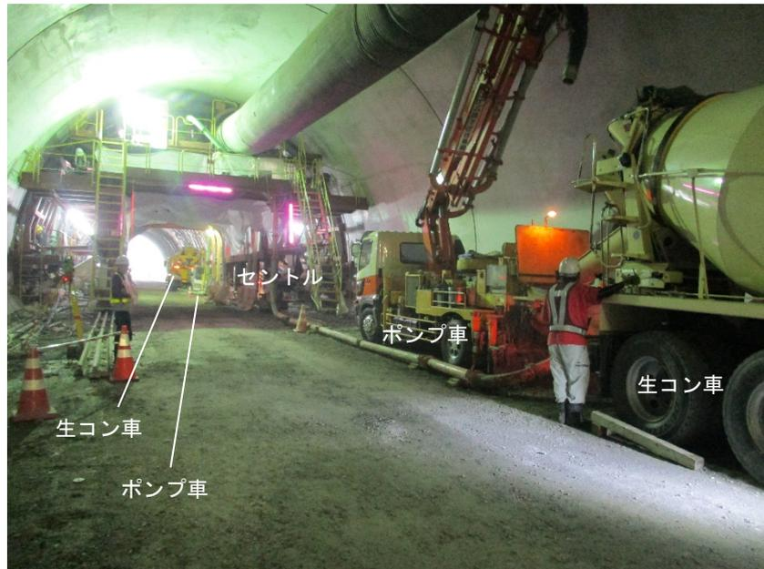
写真-1 覆工コンクリート打設状況
