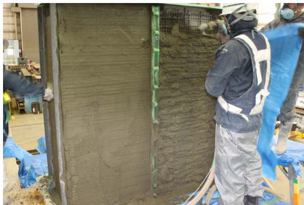
写真2 吹付けモルタル施工状況
