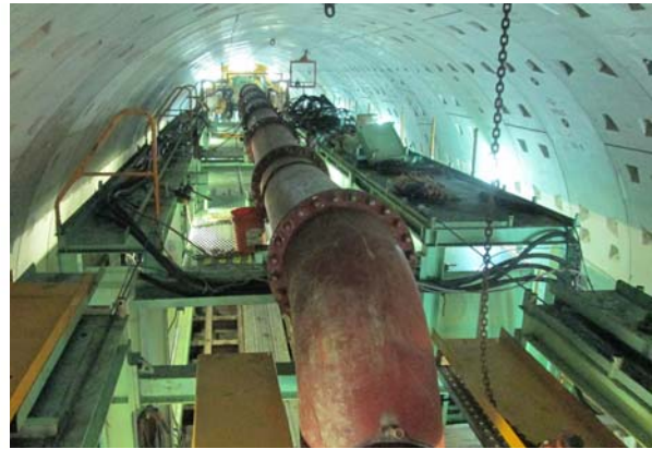
写真-3 噴発防止用鋼管 (φ600 mm、L=30m)
