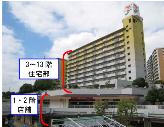
建物の全景（3階(住宅共用部)が免震階）
