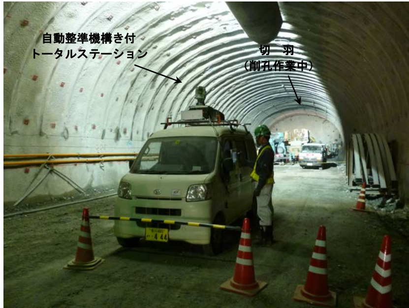
写真1 本システムによる計測状況
