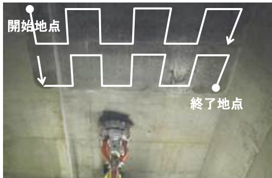
写真3 ウォータージェット装置の軌跡 (1サイクル)
