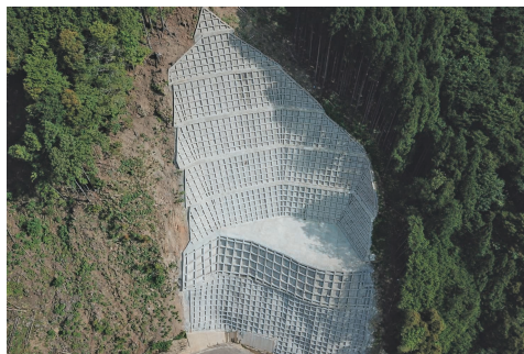
一般県道川津高野線 法面对策工事 (奈良県吉野郡)
