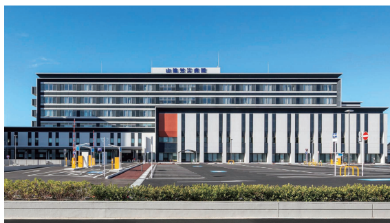
山陰労災病院 (鳥取県米子市)
