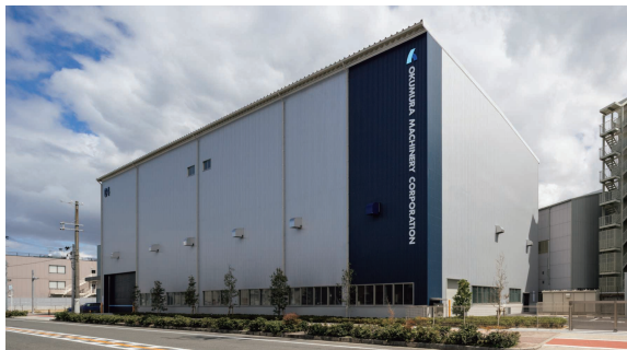
奥村機械製作株式会社 第4工場 外観（大阪府大阪市）
