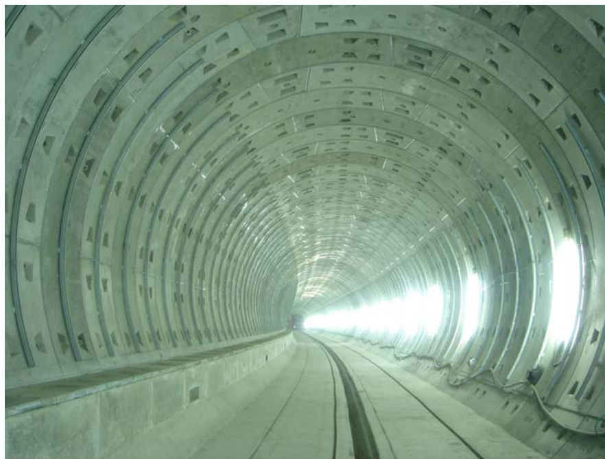
《台北地下鉄新莊線CK570G工事》 台湾 台北市
