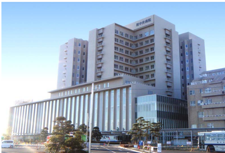
《総合病院国保旭中央病院 新本館建築工事》 千葉県旭市
