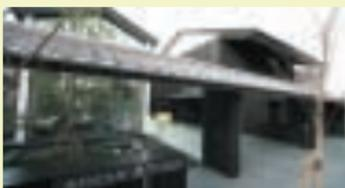
老朽化していた既存の奈良工事事務所の建て替えを兼ね、創業100周年にあわせて「奥村記念館」を建設。古都奈良に調和したデザインであるとともに、壁面には、杉の木目を生かした「杉板化粧型枠（すぎいたけしょうかたわく）」による打ち放しコンクリートを採用するなど技術的なクオリティも高い仕上がりとなっています。
