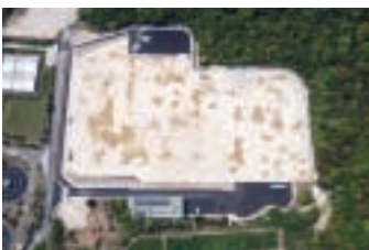
◀ 甲山調整池築造工事 (兵庫県西宮市)
