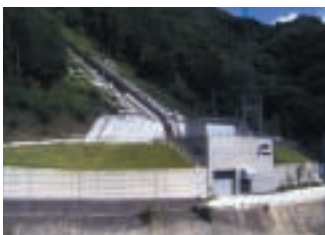
シンタイシャクガワ ◀ 新帝釈川発電所新設工事 土木本工事(第二工区) (広島県庄原市)
