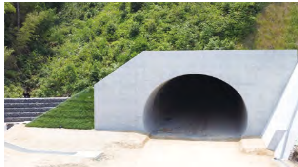
道路:三隅・益田道路筒見トンネル工事(鳥根県浜田市)
