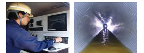
下水道管路のTVカメラ調査(左)、改築(右)
