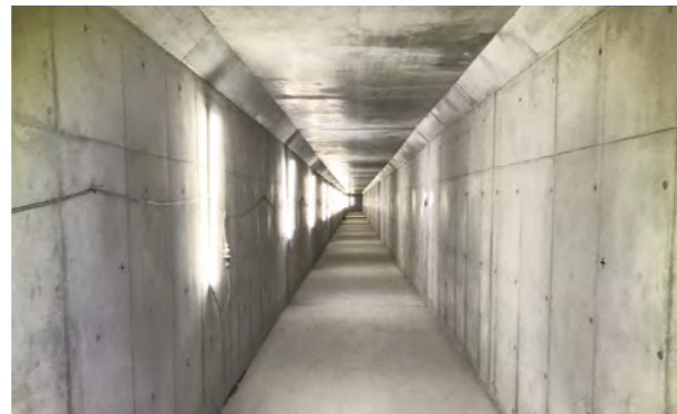
下水道:八王子水再生センター 放流渠耐震補強その2工事(東京都八王子市)
