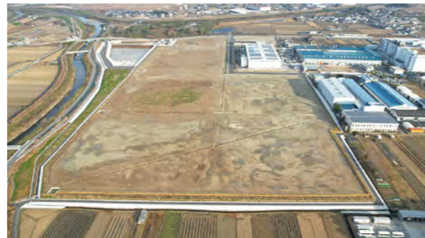
土地造成:唐院工業団地周辺地区整備工事(奈良県川西町)
