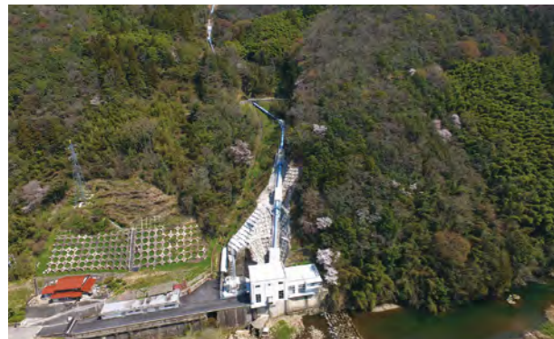
発電施設:三隅川発電所 発電設備更新(水圧鉄管・導水路)工事(鳥根県浜田市)
