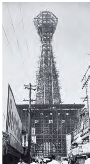
新世界にそびえる建設中の二代目通天閣
