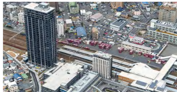
共同住宅、他:多治見駅南地区再開発【免震】(岐阜県多治見市)
