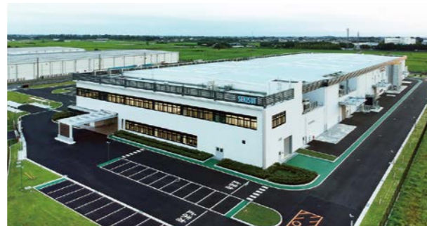
工場:積水成型工業株式会社 関東工場新生産棟(群馬県板倉町)
