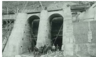
建設中の君田水力発電所取水口
