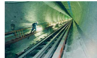
神流川発電所工事 の長大斜坑
