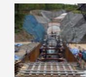
新設導水路(施工中)
