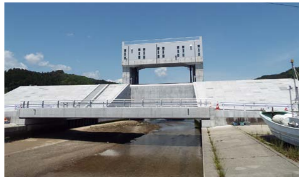
港湾・空港:二級河川大沢川筋大沢川水門土木工事(岩手県山田町)
