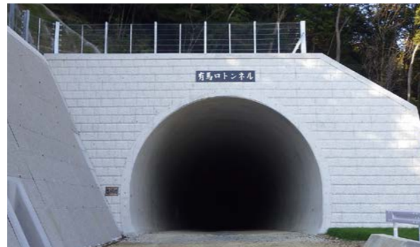
道路:(仮称)有馬口トンネル築造工事(兵庫県神戸市)
