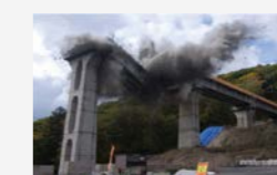
PC桁発破解体
