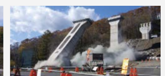
橋脚発破解体
