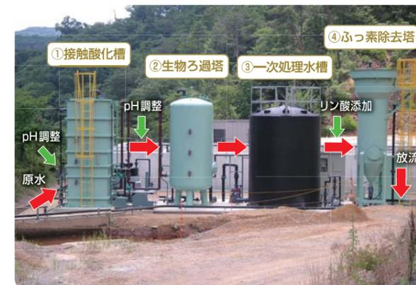
生物接触ろ過法と晶析法を併用した水処理技術を適用したプラント
