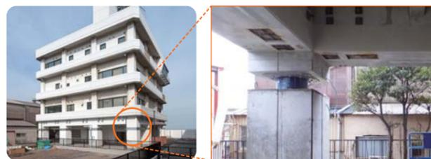
関門海峡海上交通センターの外観 免震装置の設置状況(施工中)
