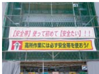
工事関係者の安全意識の向上推進例
