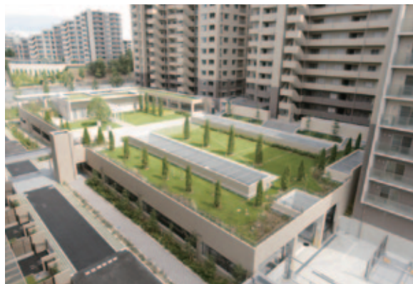
駐車場棟の屋上緑化
