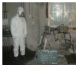
施工中の粉塵およびダイオキシン類の濃度測定
