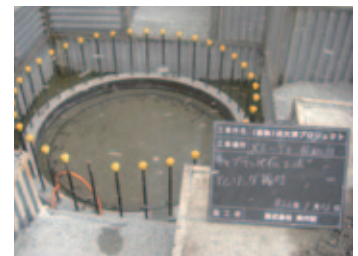
キャプテンパイル工法の施工状況
