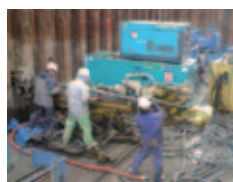
水平浄化井戸の設置
