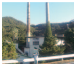
焼却施設および煙突の養生シート設置前
