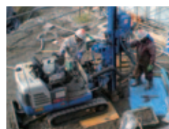
鉛直浄化井戸の設置
