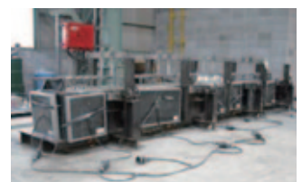
発熱パネル取り付け状況
