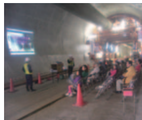
地元住民の現場見学会 (札幌支店幸連トンネル工事所)
