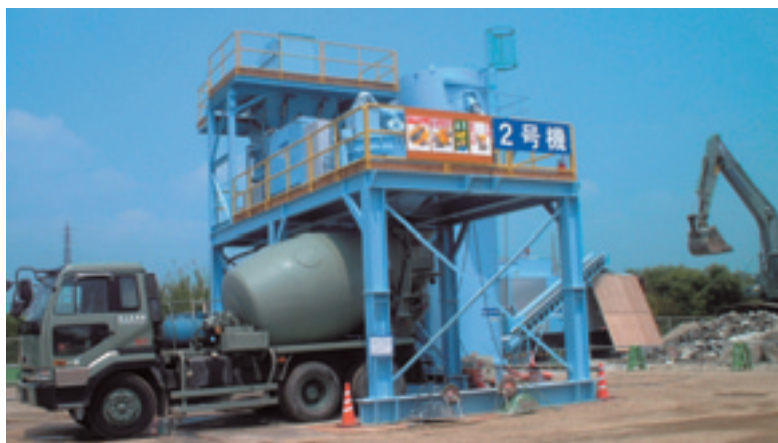
リ・バース号(2号機)による製造状況
