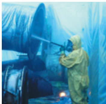
除染作業状況
