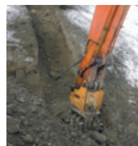
ツインヘッダー機による凍土切削
