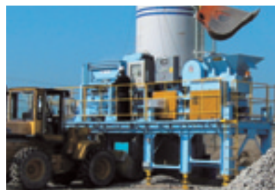
リ・バース号(1号機)による製造状況
