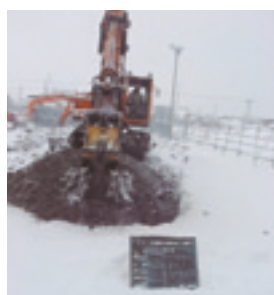
ツインヘッダー機による凍土切削
