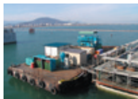
濁水処理施設
