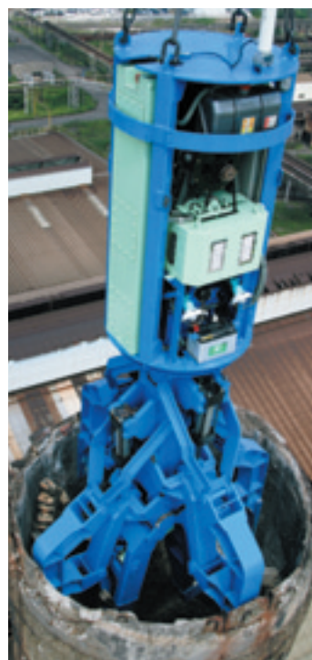
煙突レンガ解体装置
