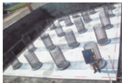
適用事例(均しコンクリート)
