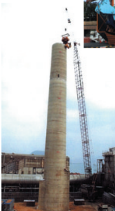
煙突解体ロボット(NOCC工法)
