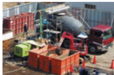
浸漬処理工法による実証試験状況
