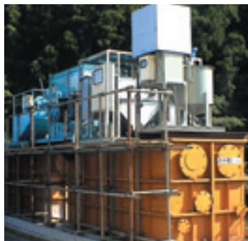
ダイオキシン排水処理システム
