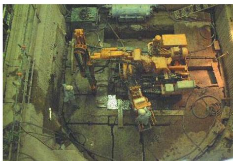
低公害岩盤破碎工法(打梨発電所工事所)
