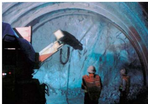
石炭灰利用吹付けコンクリートによる施工
